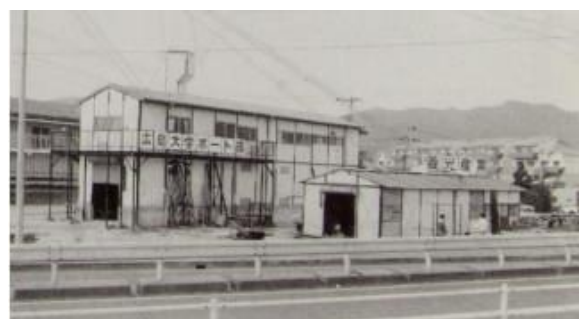
放水路下流移転後の艇庫 現役時代、艇庫移転/西条移転開始の時期に重なる
