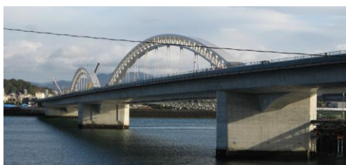
2014年に完成した ⑮広島南道路橋
