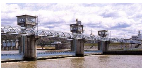
放水路始点、祇園水門
