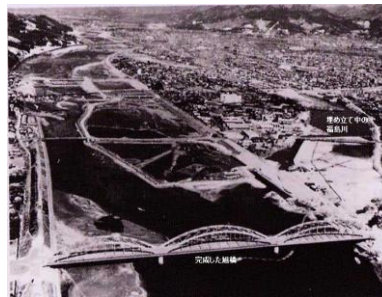
1960年旭橋完成時、上流は掘削中
