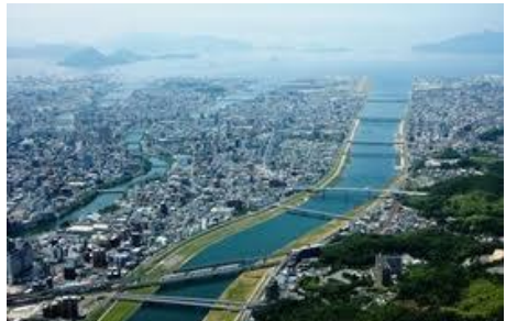
上流より放水路を見下ろす
